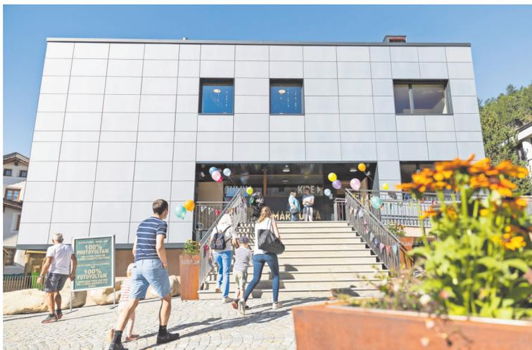
Das neue Gebäude welches auf allen vier Seiten mit Solarzellen versehen ist.
